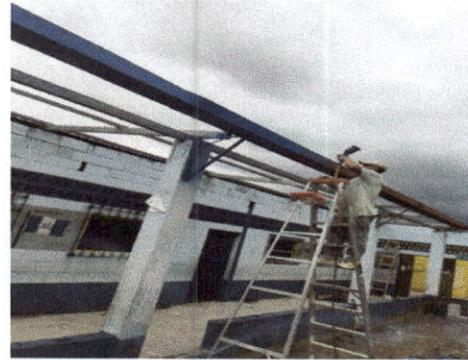
sustitución de la bajada de agua pluvial, sustitución de soporte de madera por metal, mantenimiento del canal de metal, Modulo 3 corredor
