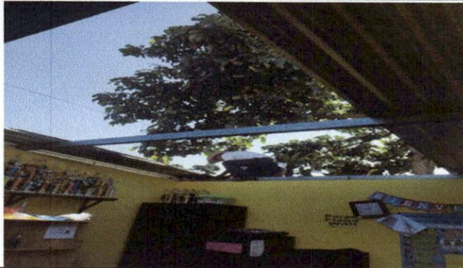
sustitución de lamina, por lamina troquelada aluzinc, y sustitución de madera por metal modulo 1 direccion
