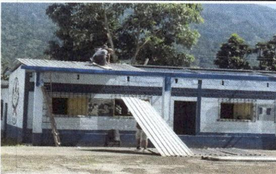
sustitución de lamina, por lamina troquelada aluzinc, y sustitución de madera por metal, sustitución de capote de lamina para lamina troquelada modulo de aulas y corredor
