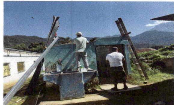
sustitución de lamina, por lamina troquelada aluzinc, y sustitución de madera por metal modulo 4 baños
